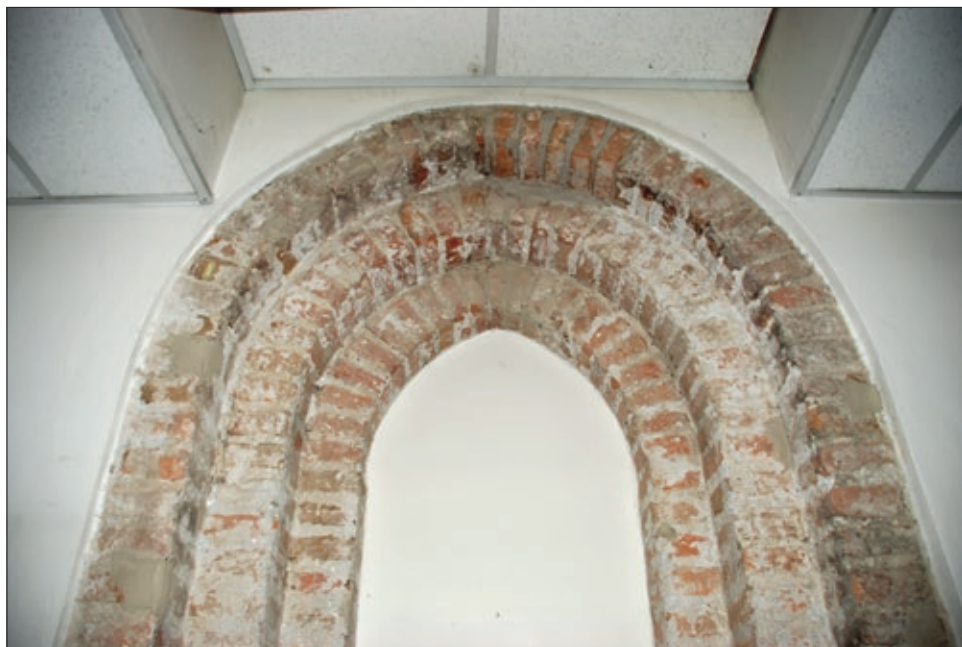
■ 12. Una delle finestre tamponate con triplice ghiera di mattoni, visibili nelle stanze a nord del chiostro
