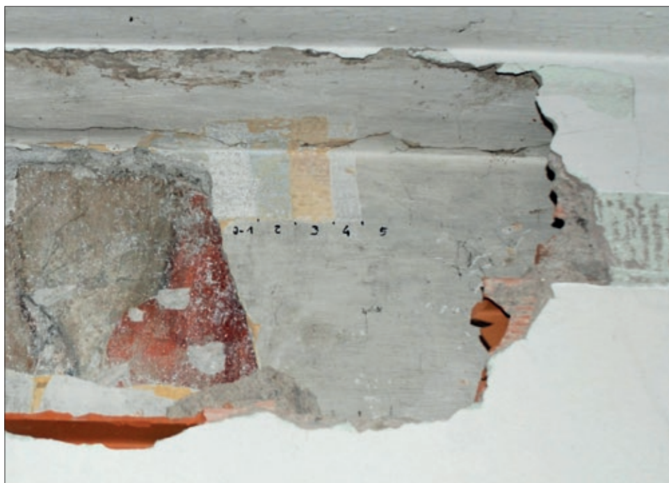
■ 11. Trento, ex casa canonica di San Marco, stanza meridionale al piano terra. Anche qui, come al piano superiore, sotto gli intonaci recenti riappaiono le tracce del parato affrescato dell'antica cappella a sud del coro
