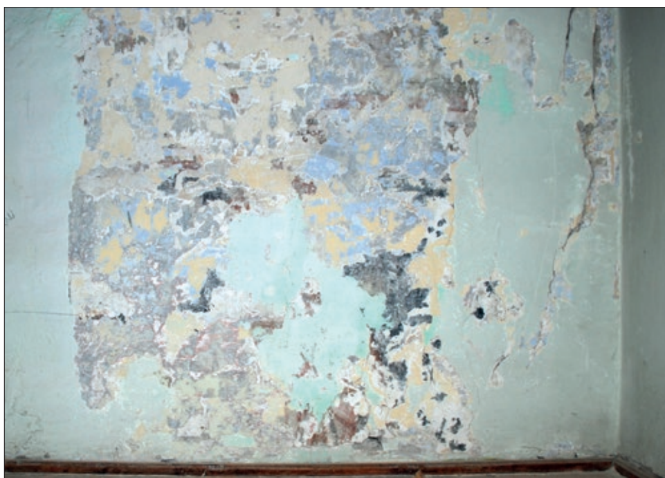
■ 10. Trento, ex casa canonica di San Marco, stanza meridionale al primo piano. Nell'apparente caos degli strati sovrapposti, si cela l'“archivio” materiale delle fasi di costruzione ed uso del complesso
